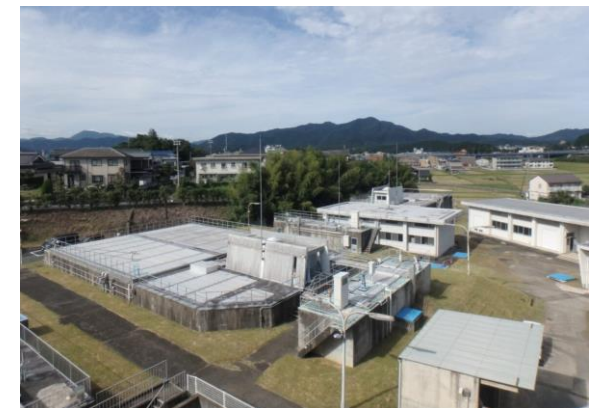
福知山市 堀浄水場
